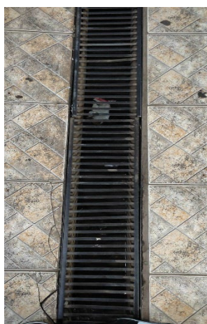
Imagem 51 – Grelha com espaçamento maior de 5 mm e sentido correlato à passagem na Escola D. Fonte: Fotografado pelo primeiro autor (2022).
