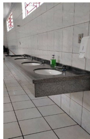
Imagem 36 – Pia do banheiro da Escola C. Fonte: Fotografado pelo primeiro autor (2022).
