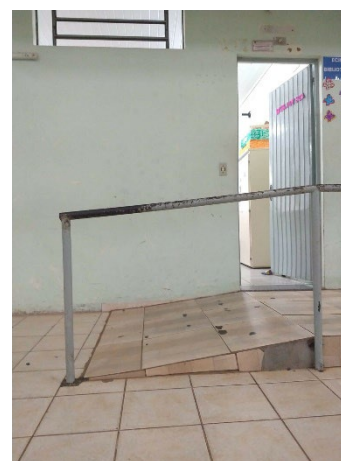
Imagem 6 – Acesso às salas de aula no piso inferior da Escola A.
