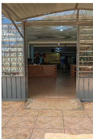
Imagem 46 – Rampa de acesso à área coberta na Escola D. Fonte: Fotografado pelo primeiro autor (2022).
