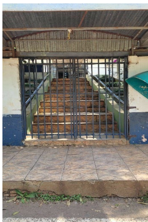
Imagem 42 – Acesso principal por escada da Escola D.
