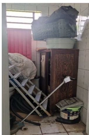
Imagem 37 – WC acessível masculino da Escola C, usado como depósito. Fonte: Fotografado pelo primeiro autor (2022).
