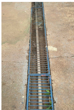
Imagem 20 – Grelha com espaçamento maior de 5 mm e sentido correlato à passagem da Escola B. Fonte: Fotografado pelo primeiro autor (2022).
