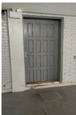
Imagem 34 – Banheiro da Escola C na outra instituição de ensino. Fonte: Fotografado pelo primeiro autor (2022).
