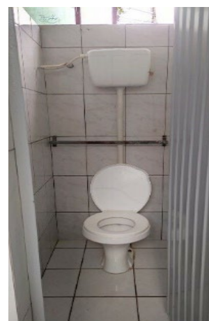
Imagem 38 – WC com uma barra de apoio na Escola C. Fonte: Fotografado pelo primeiro autor (2022).
