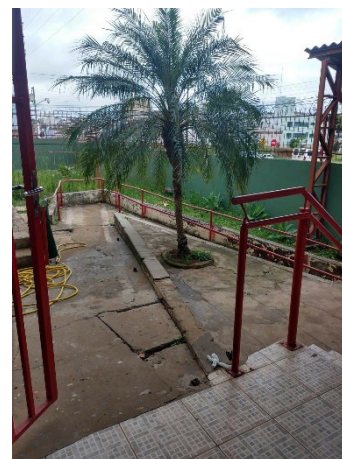
Imagem 2 – Rampa da saída de emergência da Escola A.
