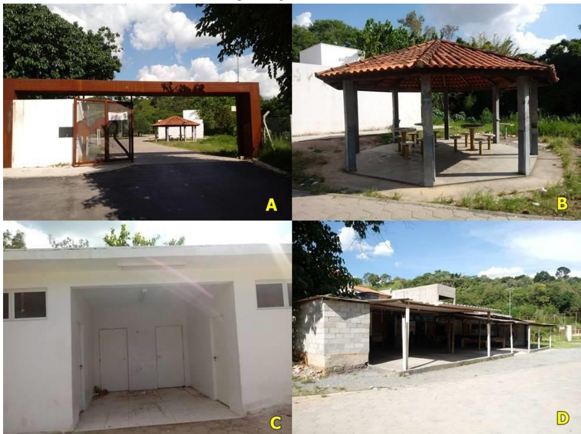
Figura 2: A. Guarita de entrada da Cachoeira da Chave; B. Quiosque; C. Estrutura abandonada dos novos sanitários; D. Estrutura que abriga dois sanitários e o bar/lanchonete
