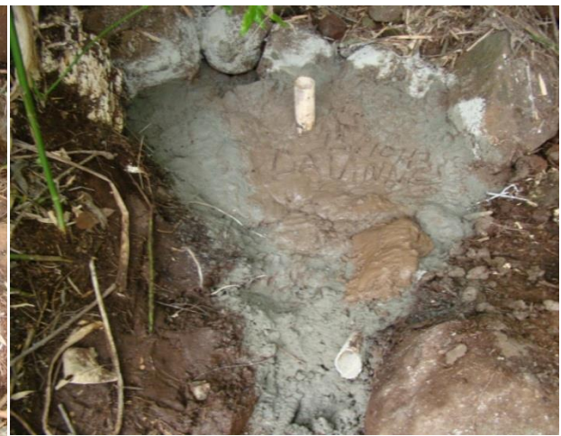
Figura VI: Nascente após a aplicação da técnica de recuperação e proteção
