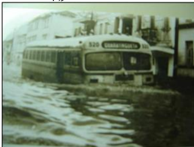
Figura 4 – 17/01/1957 – Av. Cel. Carneiro Júnior. Em frente à Casa Dois Irmãos (calçados) – Cota do terreno: 842,20 m – nível de cheia: 80 cm – Cota de cheia: 842,30 m
