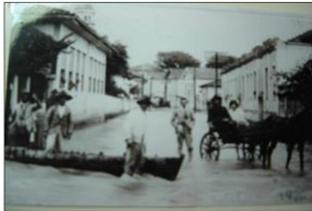
Figura 2 – 1929 – Rua Xavier Lisboa. Próximo ao antigo Posto Brasileira. Cota do Terreno 843,95 m – Nível de Cheia: 15 cm – Cota de Cheia: 844,10 m
