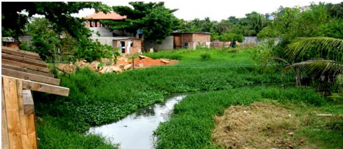
Figura 7 – Aterros e construções nas margens do rio Marinho
