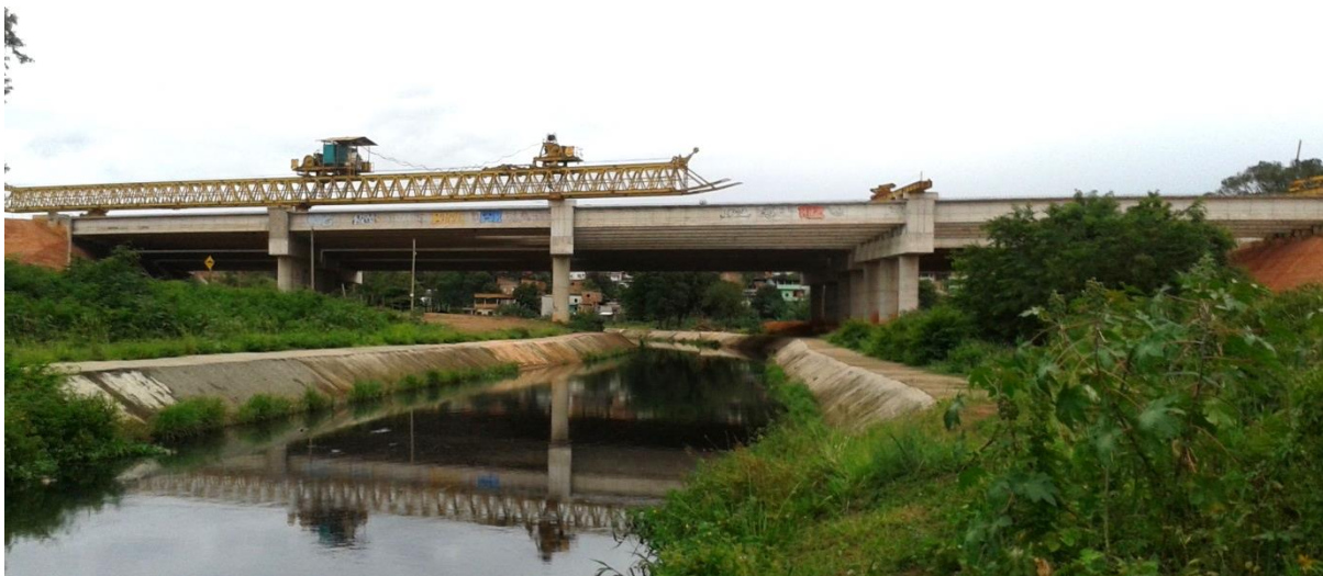
Figura 6 – Construção de ponte sobre o rio Marinho.
