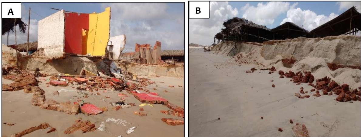
Figura 1 - Destruição de casas (A) e barracas (B)
